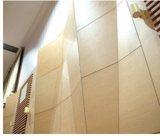
▲早良交流センターの壁 社員と大工さんが総動員して造り上げた思い出深い立体的な壁。
